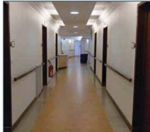
Tubes fluorescents en corniche (éclairage permanent) associés à des luminaires downlight avec lampes fluocompact (éclairage complémentaire).
