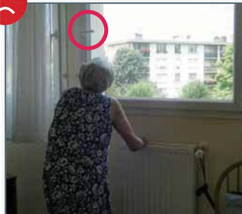
Les poignées de fenêtres doivent être positionnées à une hauteur maximum de 1m10.
